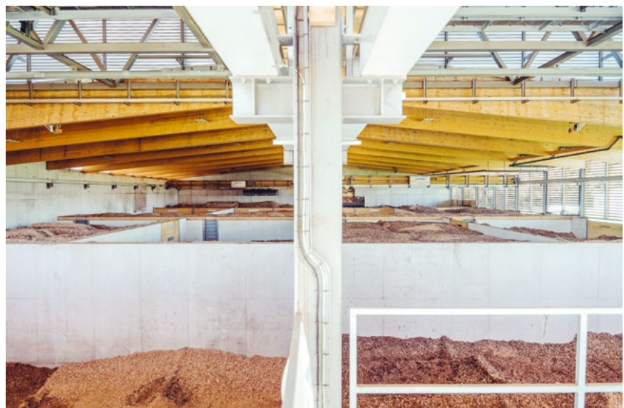
Einblick ins Trockenlager des Holzkraftwerkes
